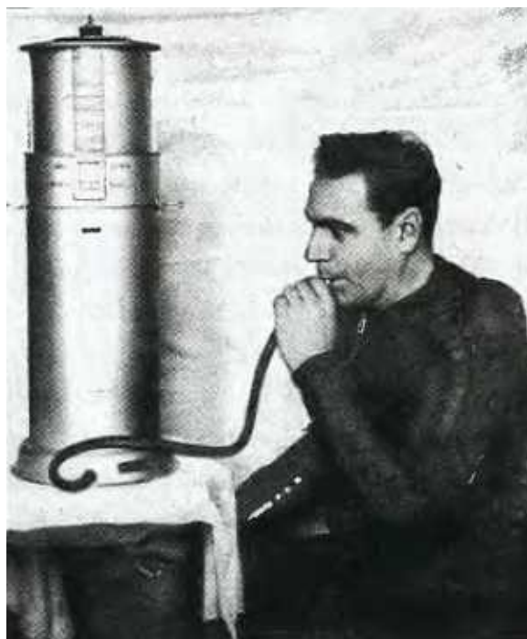
И. П. Неумывакин проверяет жизненную емкость легких с помощью водяного спирометра в высотном-компенсирующем костюме, 1960 г.
